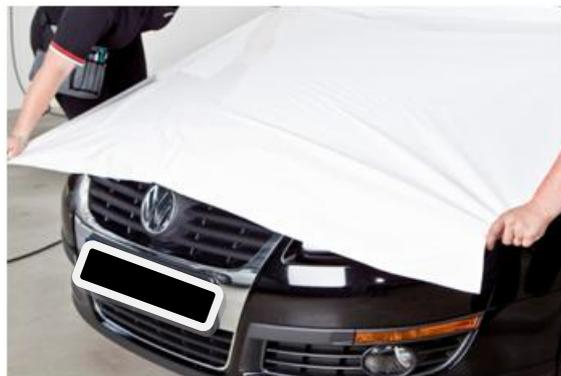
Erst bei dem ersten Rakelstrich haftet die Folie auf dem Untergrund. Ein Repositionieren nach dem Anrakeln der Folie ist möglich. Abhängig von der Umgebungstemperatur kann der Einsatz von Wärme dabei hilfreich sein.
